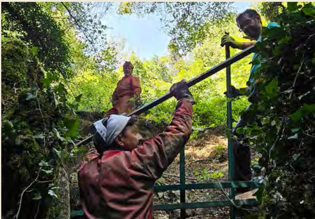
Lavori per la protezione dell'ingresso (foto di Massimo Dondi).
