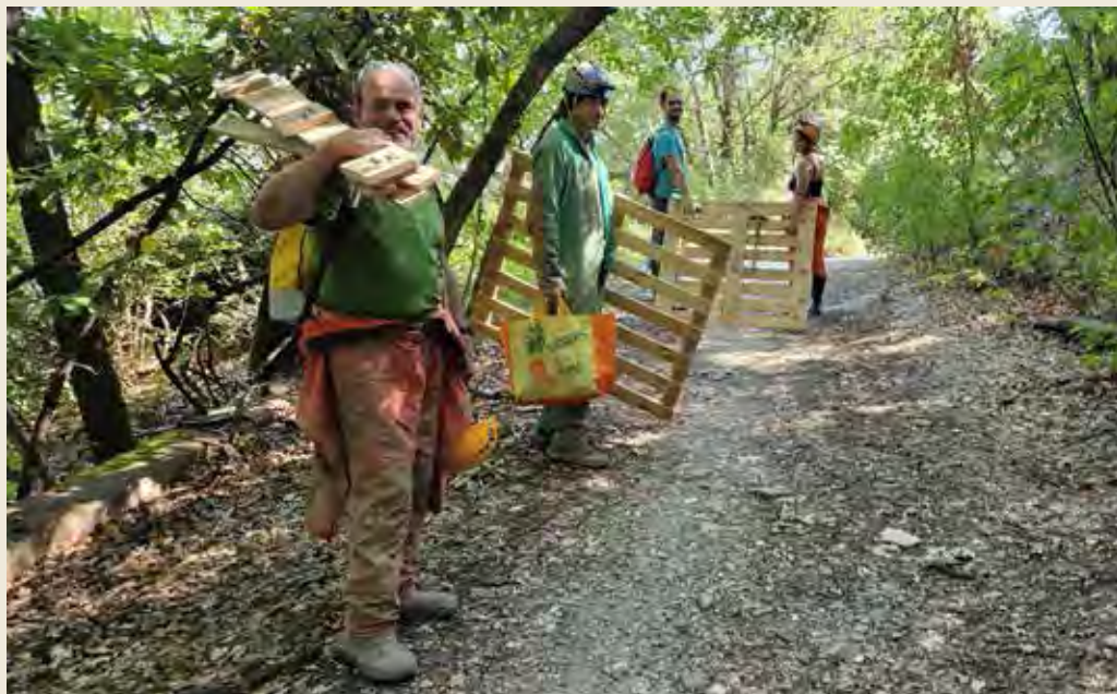
L'avvicinamento con i materiali per la protezione dell'ingresso (foto di Massimo Dondi).
