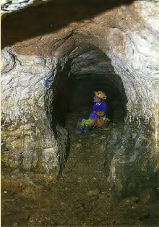
Fig. 10 - In questo caso l'escavazione della galleria è stata impostata seguendo la traccia del canale di volta, ben visibile dal differente colore presente sulla roccia.
