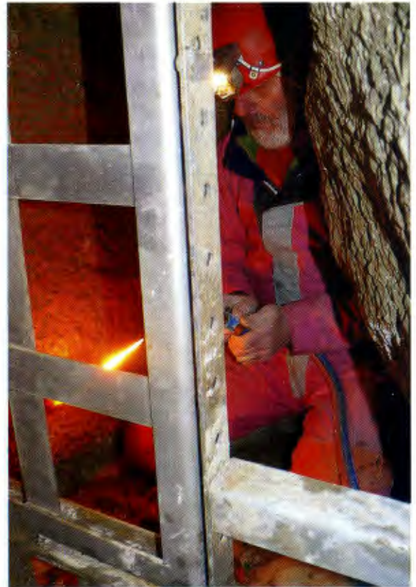
Inghiottitoio dell'Acquafredda - La saldatura dei bulloni
