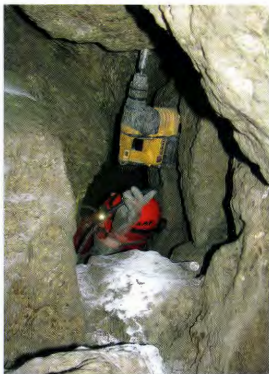
Grotta Gortani - Preparazione dei fori per la barra di sezionamento
