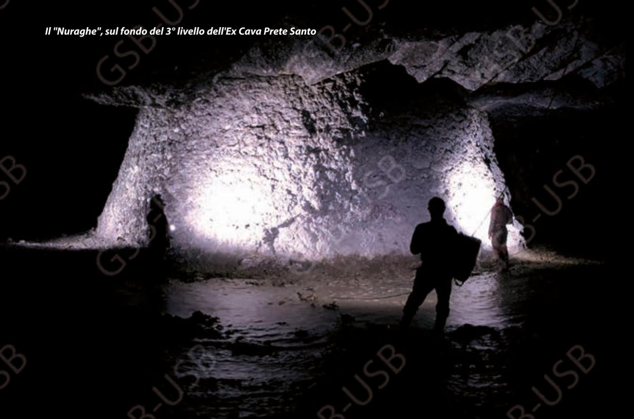
solido le cui fattezze rammentano da vicino il Nuraghe Losa, in buona sostanza un tronco di cono costipato attorno al pilastro frale, fra pavimento e volta, con blocchetti di gesso impilati e stuccati a malta.
