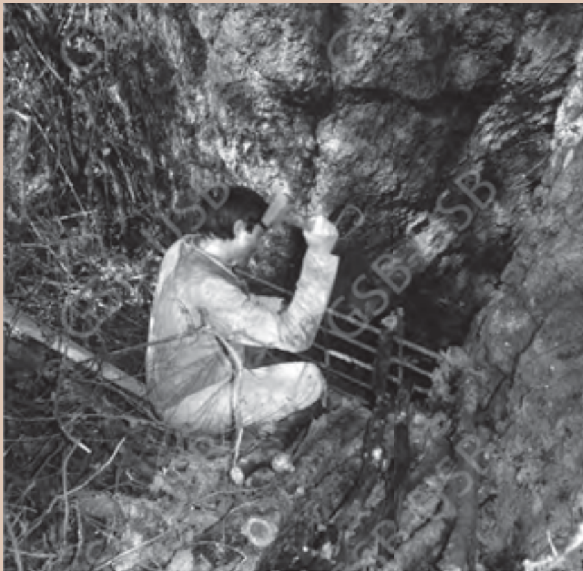
2003: Il montaggio della grata di contenimento
