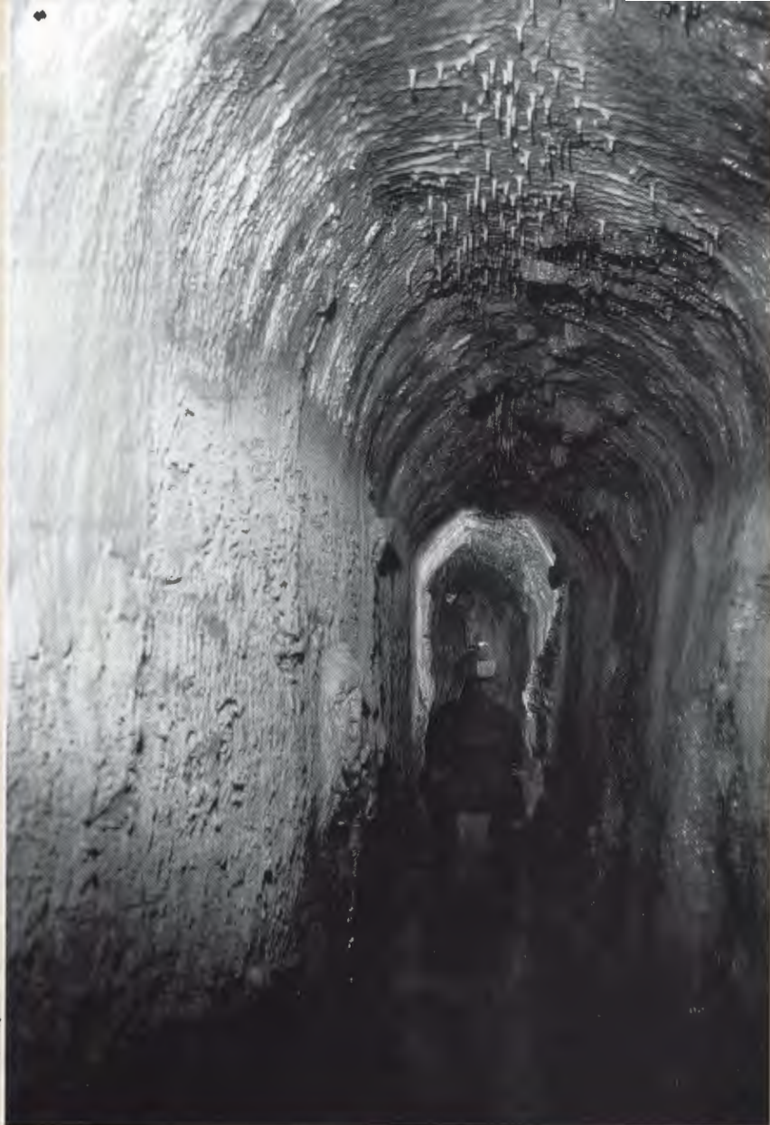
Fig. 5 - A sinistra un esempio di punto d'incontro fra tratti di cunicolo a vergenza opposta (da "Acquedotto 2000").
