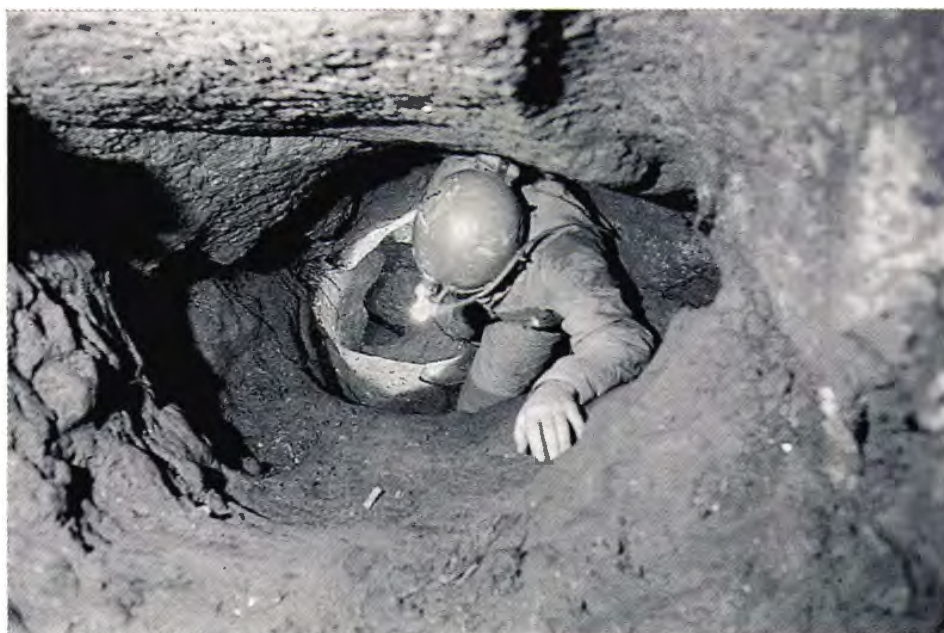
Il cunicolo scavato
