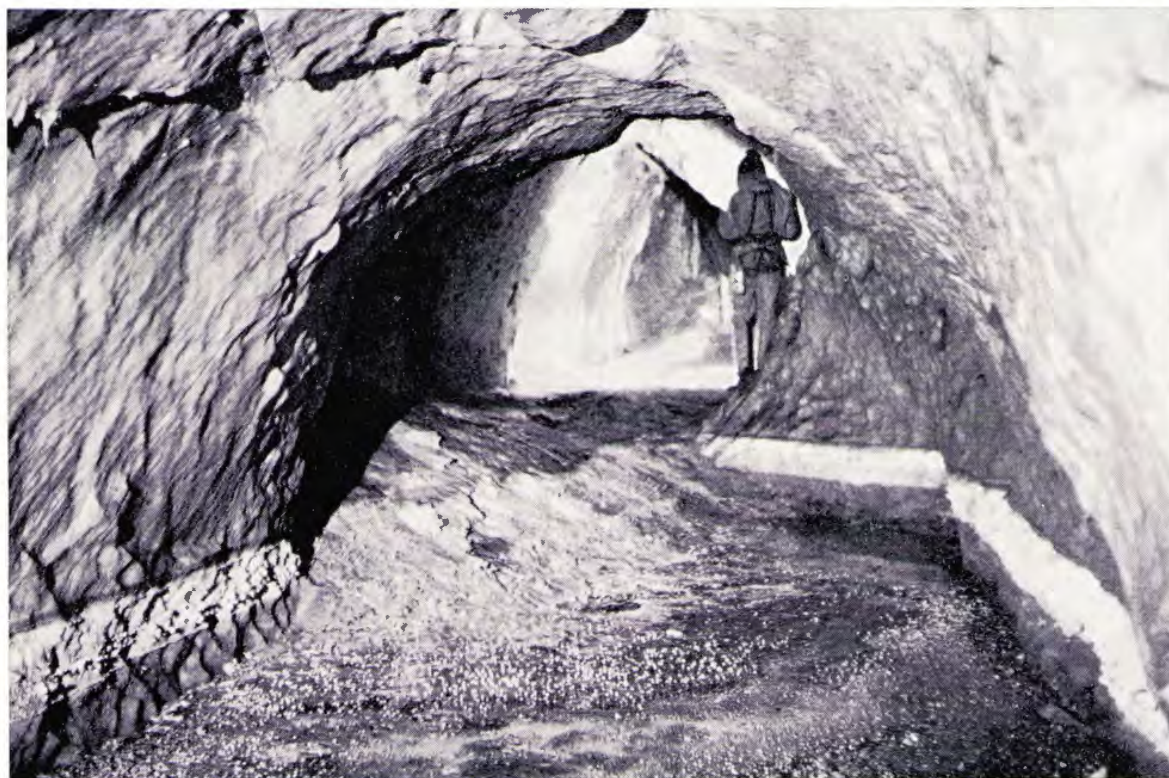
La galleria sopra il P. 20
